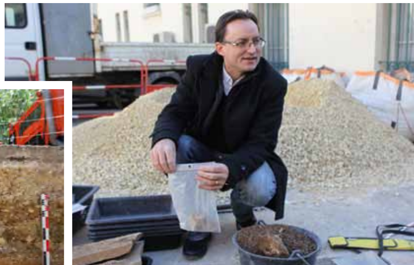
Marc Bouiron sur le chantier de déviation de réseau pour la station Garibaldi.
